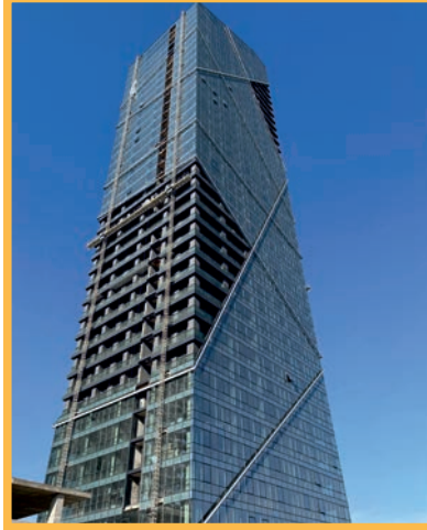
SOL CEPHE II. AŞAMA
